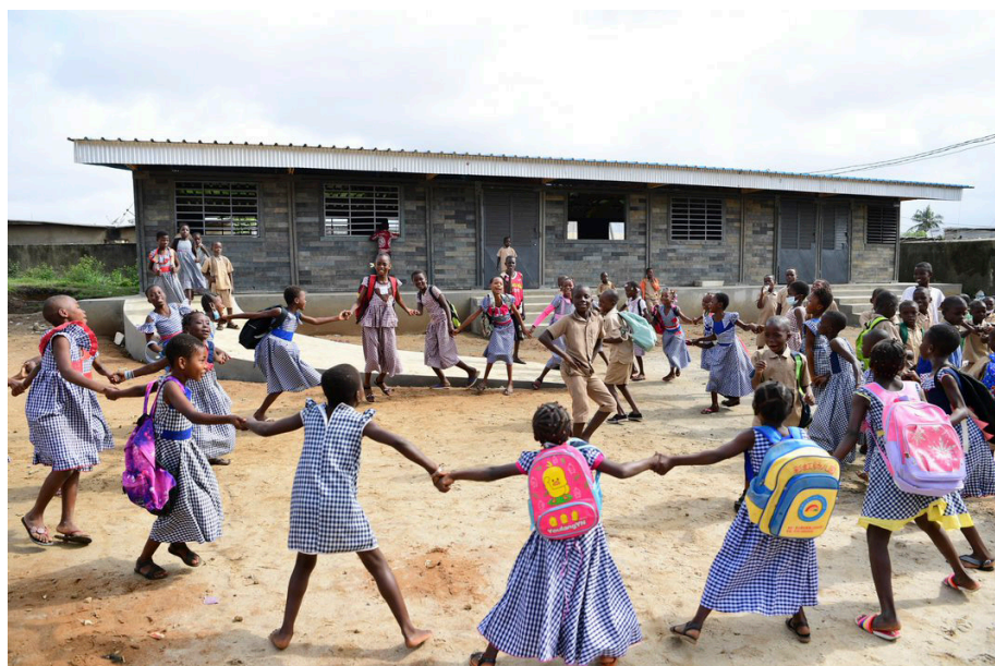
Skole i Elfenbenskysten bygget av resirkulert plast. Foto: UNICEF
