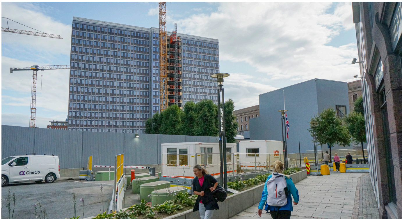
Regjeringskvartalet fremstår fremdeles som en byggeplass, men om noen år får departementene igjen flytte inn. Foto: Magne S. Otterdal
